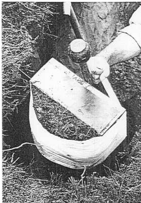
**Fig.13.** Un bendaje previene el deterioro de la columna
